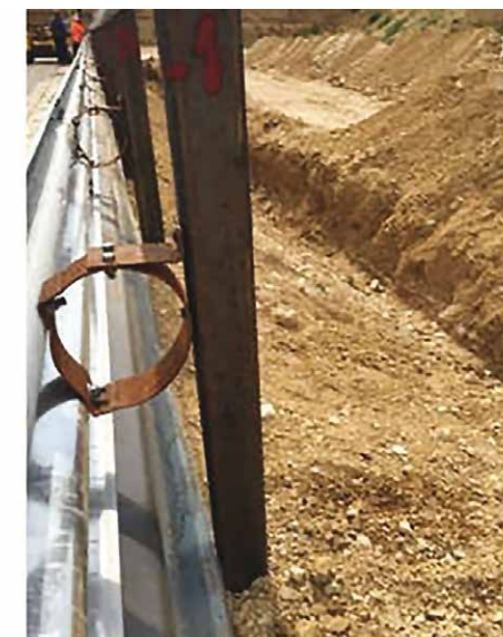
1A, 1B e 1C. La prima gamma di barriere stradali ANAS continue in un crash test su arginello ridotto (anno 2016)
