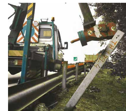
7A e 7B. La calibrazione del terreno in situ mediante prove dinamiche e simulazioni
