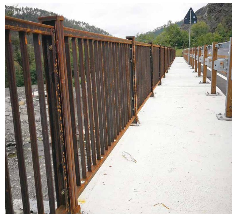
3. Il parapetto Raily PSP-X in acciaio Corten
