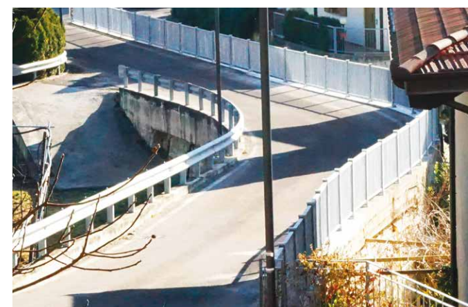
2. Il parapetto Raily PSP-X in acciaio zincato
