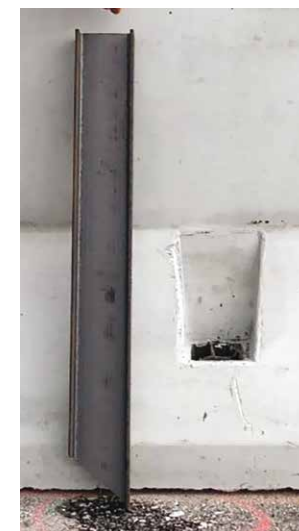
6A e 6B. Il sistema di ancoraggio della barriera NDBA su rilevato
